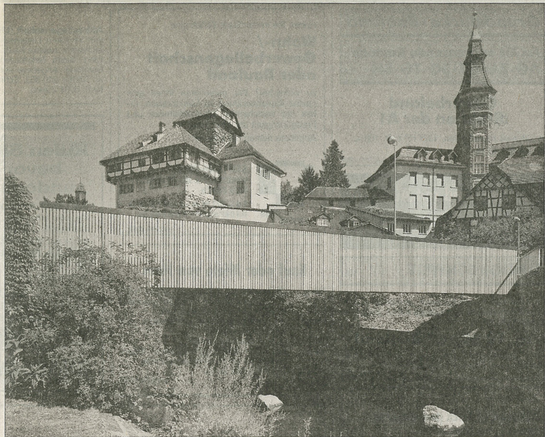
Zeitgenössische Holzbrücke: Walter Bieler's Schlossmühlesteig in Frauenfeld. 2003. (Bild Ralph Feiner)
